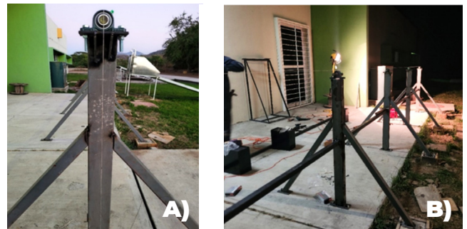
Figura 15. A) Estructura base del CSCP. B) Colocación de las chumaceras en las bases restantes. Fuente: ambas de elaboración propia
