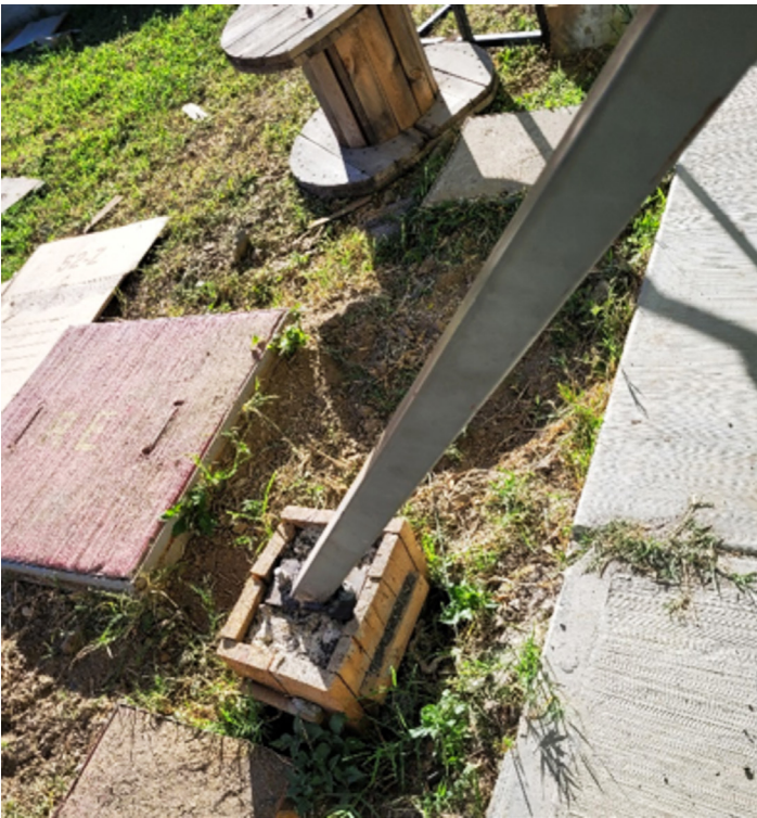
Figura 13. Cimiento para la colocación de la base estructural del CSCP. Fuente: elaboración propia
