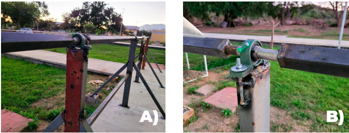
Figura 16. A) Estructura del eje de torsión acoplado a la chumacera. B) Acercamiento a la estructura. Fuente: elaboración propia
